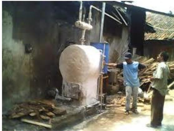
**Gambar 1. Boiler di Industri Tahu Tempe**
