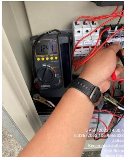
Gambar 5. Proses pengambilan data tegangan.
