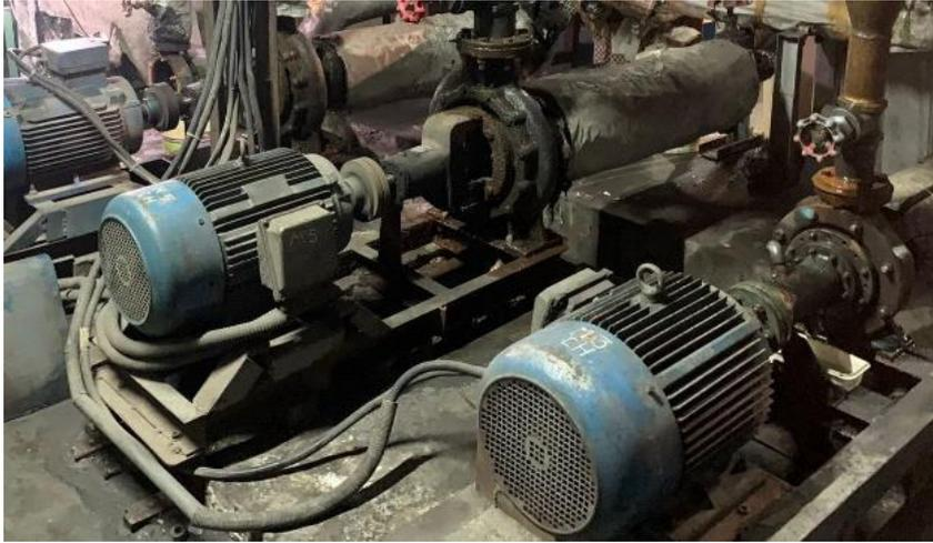
**Gambar 1. Pompa Sentrifugal EBARA 65x50 FSS4JA pada TCU Mesin Casting.**
