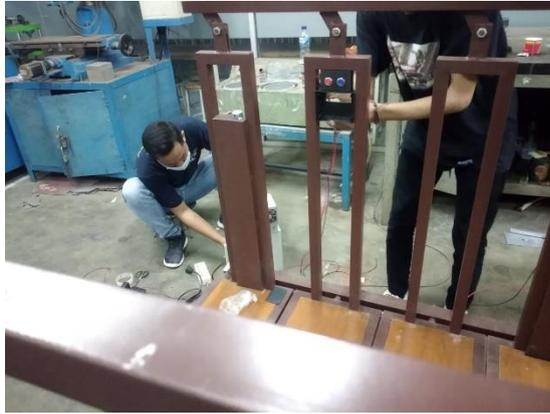
Gambar 5 Pemasangan tombol *push button* serta pemasangan instalasi kabel pada *flexstep*
