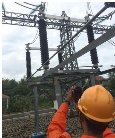
**Gambar 6. Thermovisi pada kontak dan klem PMS**
