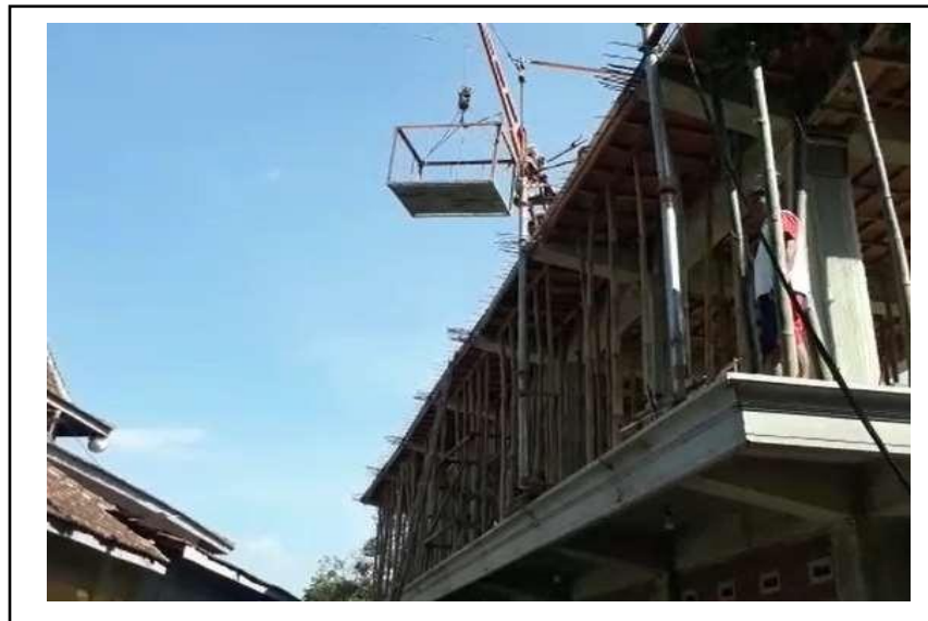
Gambar 6. Pelaksanaan kegiatan pendampingan pengecoran dengan lift cor
